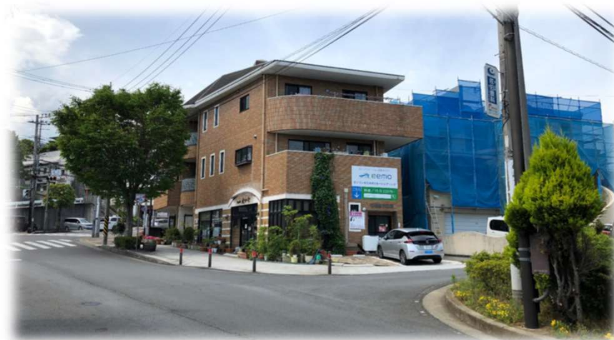
城山第一ステーション
